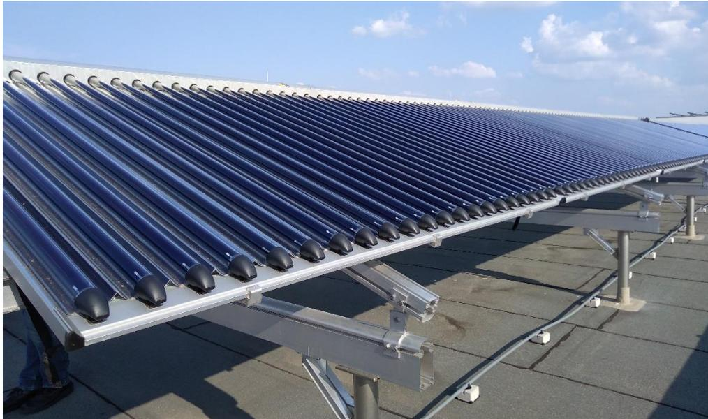
Abbildung 23: Kollektoranlage mit Flachdachaufständerung in Berlin (Foto: Hamburg Institut)
