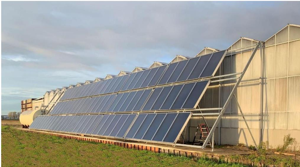
Abbildung 24: Installation einer Kollektoranlage auf Traggerüst vor einer Fassade (Foto: GREENoneTEC/HRsolar)
