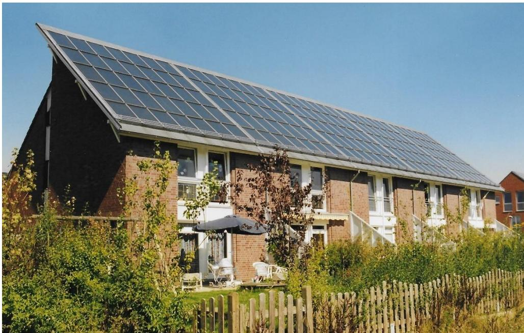
Abbildung 22: Solarkollektoranlage als „Solar-Roof“ in Hamburg (Foto: Hamburg Institut)
