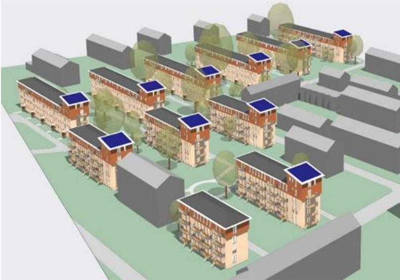
Abbildung 12: Modernisierte Ford-Siedlung mit den Solarkollektoren auf den Pultdächern (Grafik: EnergieServicePlus GmbH)
