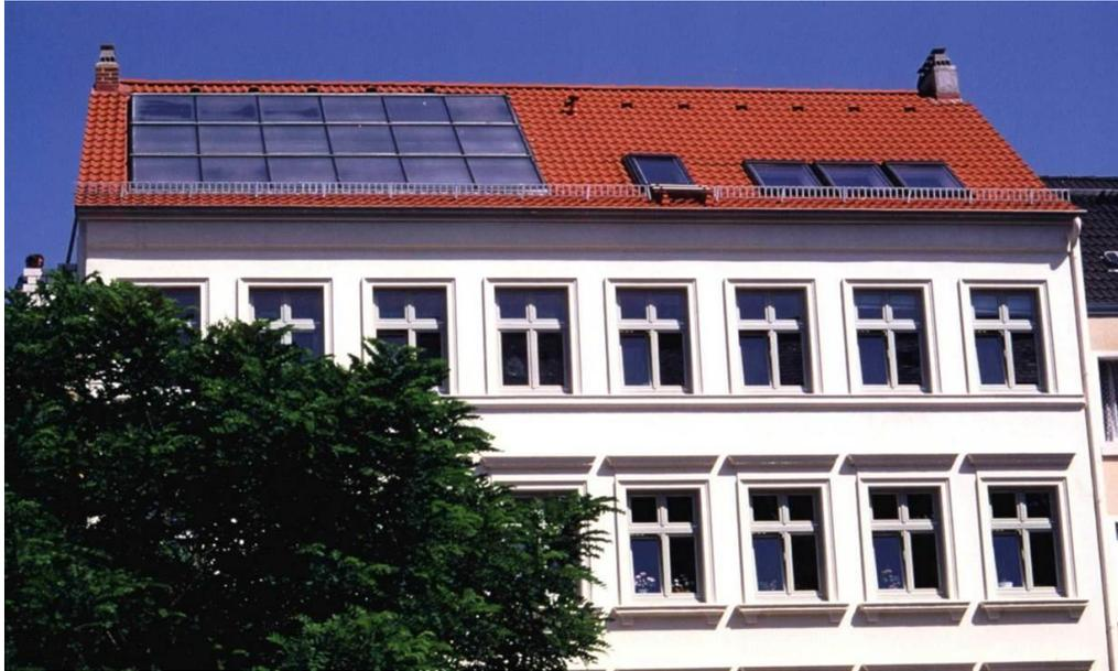
Abbildung 21: Dachintegrierte Solarkollektoranlage (Foto: STEG Hamburg GmbH)
