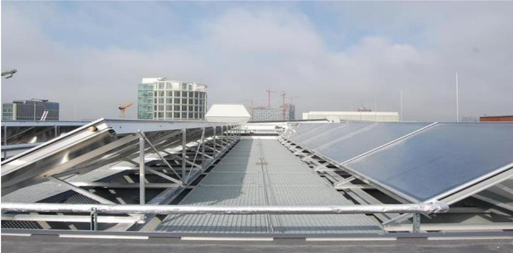
Abbildung 11: Solarthermiekollektoren zur Versorgung der Hamburger Hafen-City (Foto: Warmuth)
