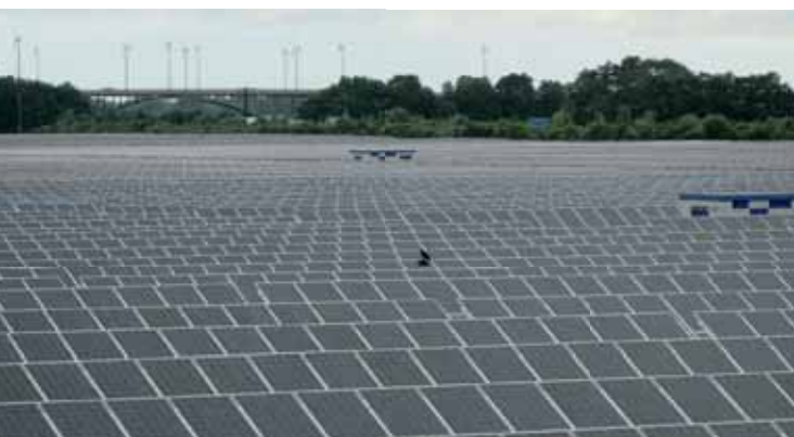
BILD 21: Großanlage mit fehlender struktureller Gliederung.
