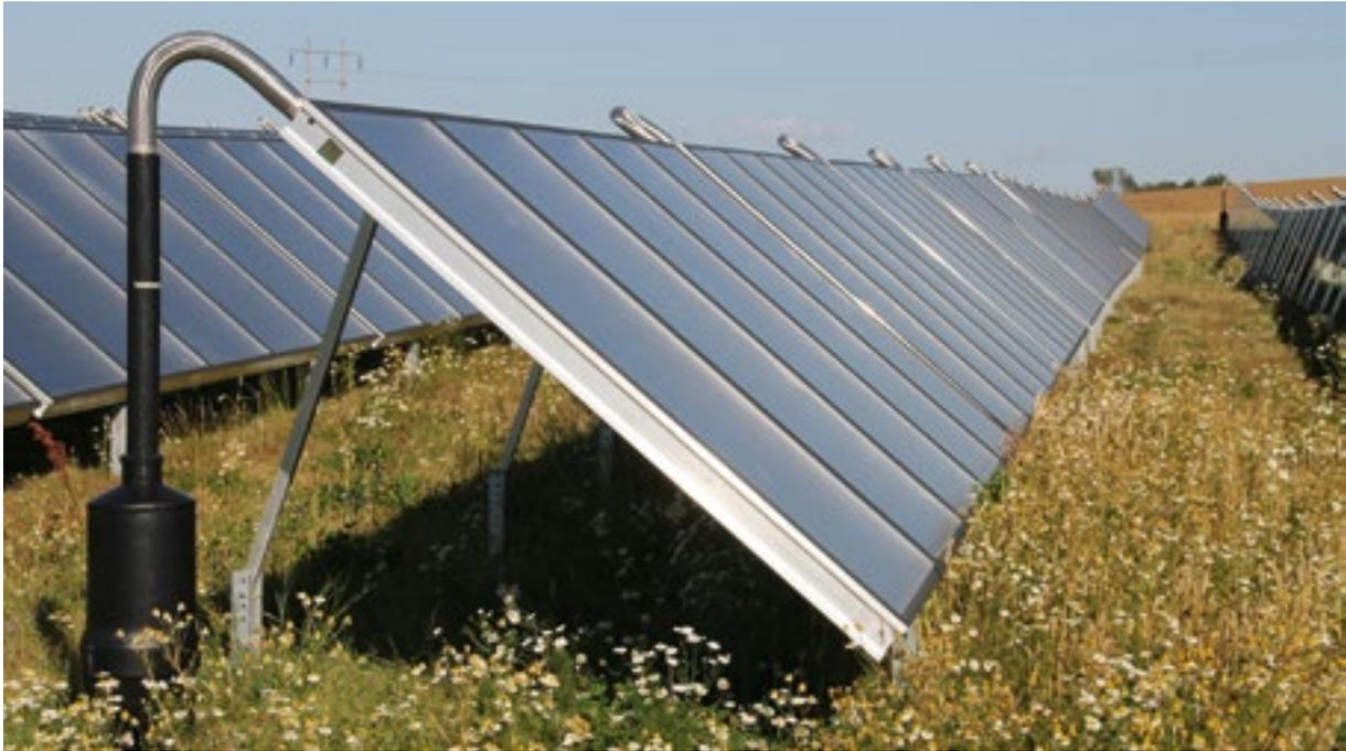
Abbildung 12: Flachkollektoranlage in Freilandaufstellung (Foto: Hamburg Institut)
