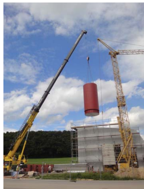
Einbau des Pufferspeichers per Kran
