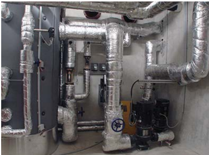
Einbindung der Solarthermieanlage in das Fernwärmenetz
