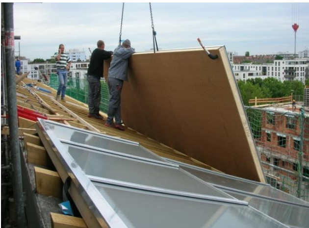
Abbildung 7: Dachintegrierte Solarkollektoren auf Mehrfamilienhäusern (linkes Bild, Quelle: Solites); Solare Nahwärme Stuttgart Burgholzhof (rechtes Bild, Quelle: EnBW Energie Baden-Württemberg AG)
