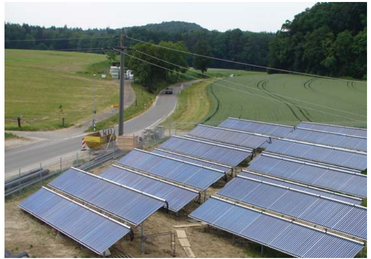
Freilandaufgeständerte Vakuumröhrenkollektoren
