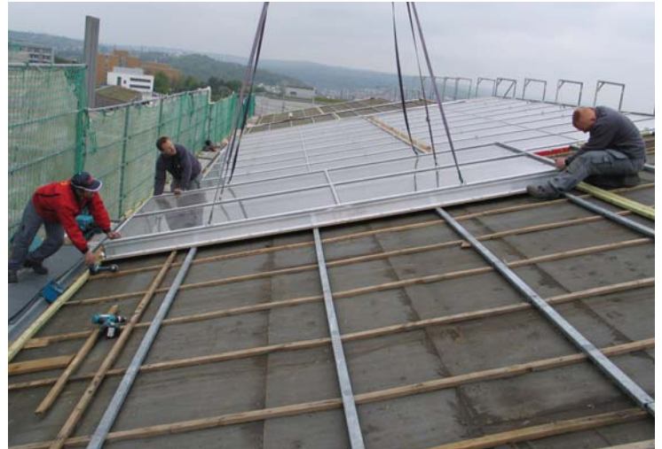
Montage der „Solar Roof“-Kollektoren
