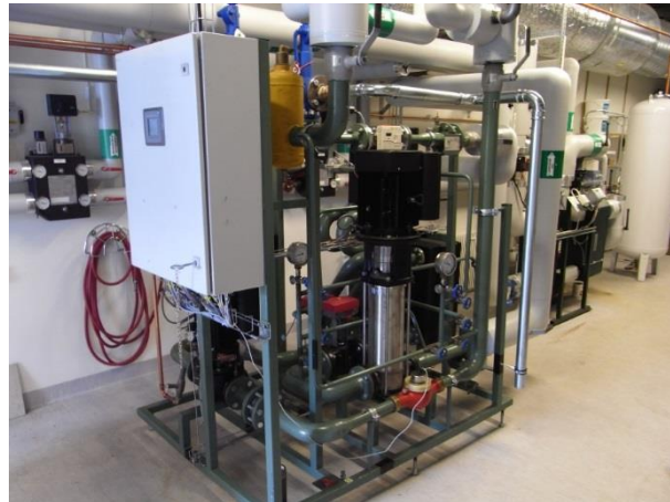
Abbildung 9: Dezentral eingebundene Solaranlage in Gardsten (SE) (linkes Bild); Übergabestation zur Wärmeabgabe an das Netz des Herstellers Armatec (rechtes Bild, Quelle: Armatec/Solites)
