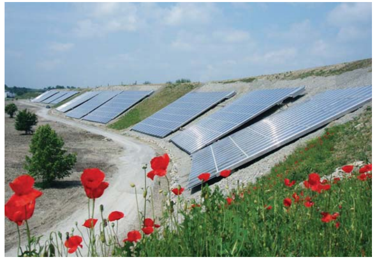
Solkollektoren auf dem Lärmschutzwall
