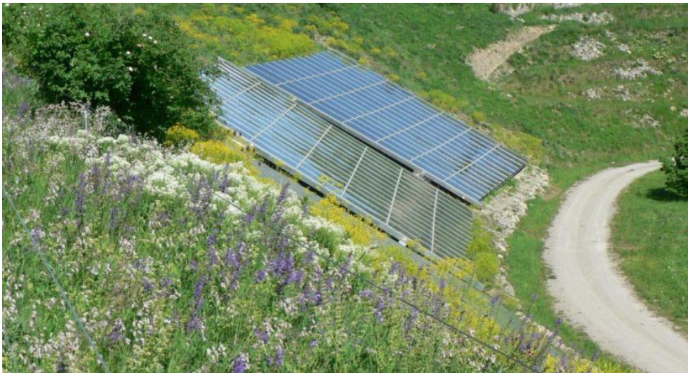
Abbildung 2-30: Lärmschutzwall mit Solarkollektoren in Crailsheim (Foto: Lorinser)
