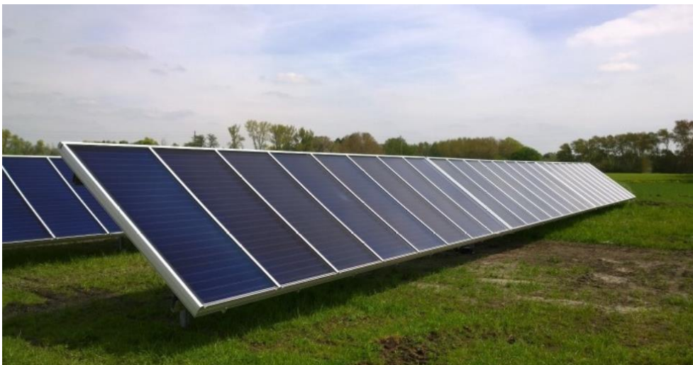
Abbildung 2-12: Freiflächenanlage für Prozesswärme in Bohlingen (Quelle (Energieportal24, 2016))
