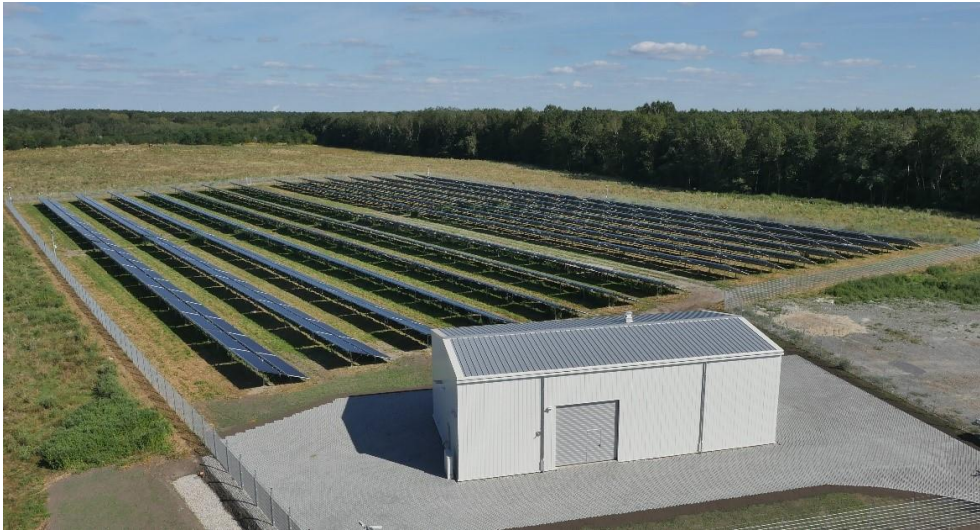
Abbildung 2-15: Solaranlage in Senftenberg (Foto: Ritter XL Solar)
