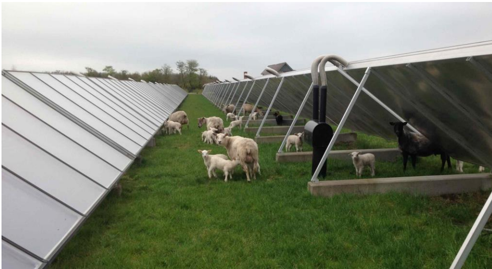
Abbildung 2-17: Schafbeweidung im Kollektorfeld (Foto: Hamburg Institut)
